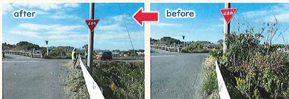
軽トラック3台分の雑木を除去し、見通しが良くなりました(田久橋周辺)
