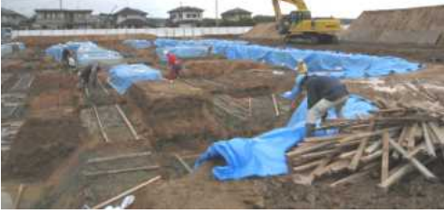
センターの建設工事が始まりました(写真 12/8)
