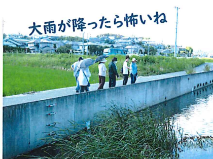
自治区内の危険箇所を確認
